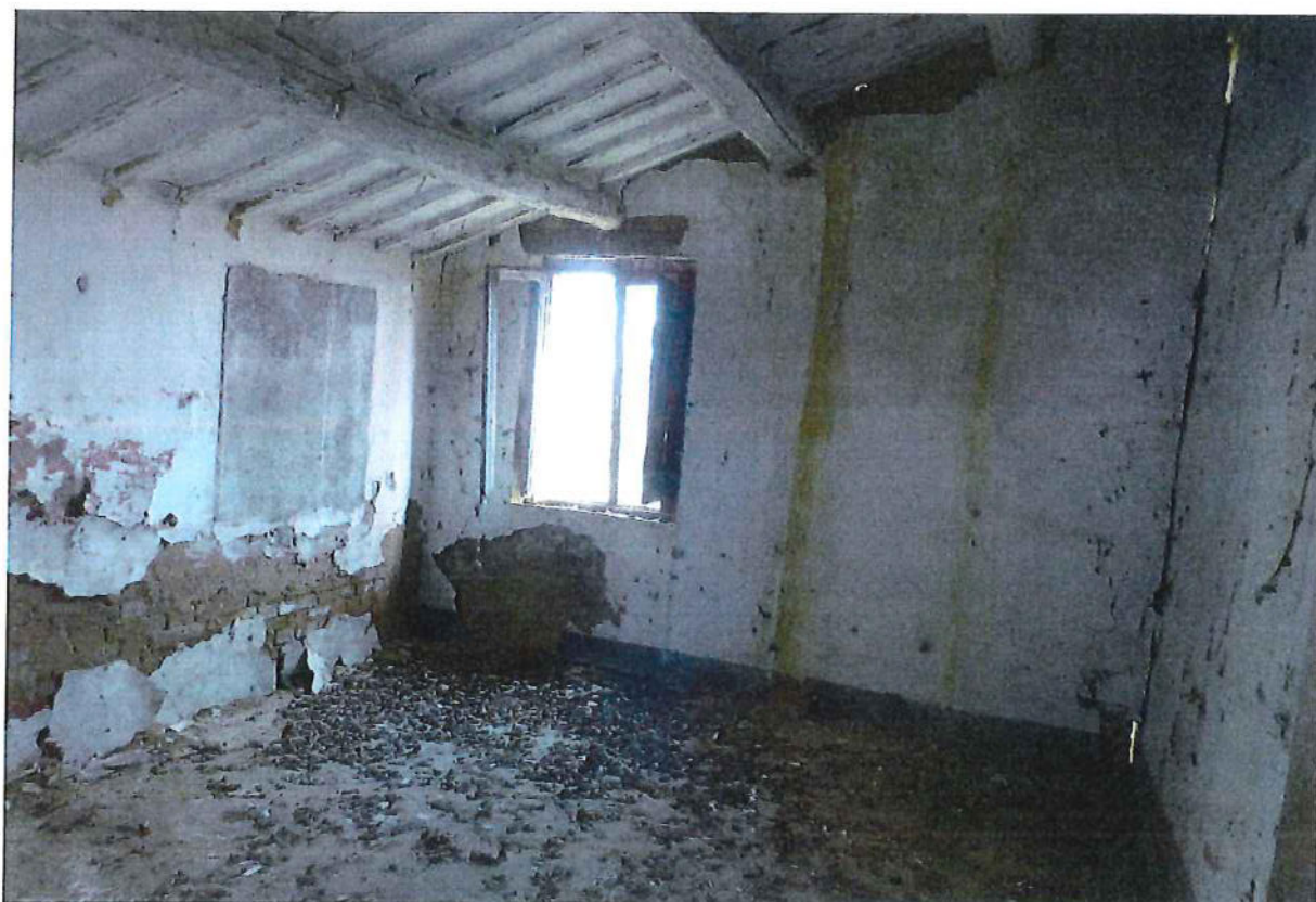
Figura 8: SOTTOTETTO CORPO AMPLIAMENTO
